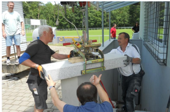
Herber Zeiher und die AH-Spieler beim Setzen der neuen Treppenstufen am Sportheim
